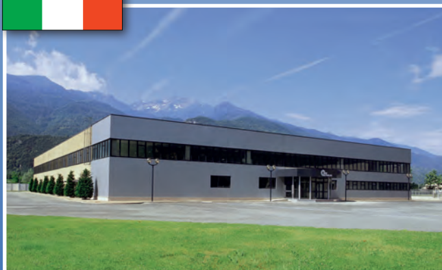
AUTOBLOK Werk in Caprie-Torino
